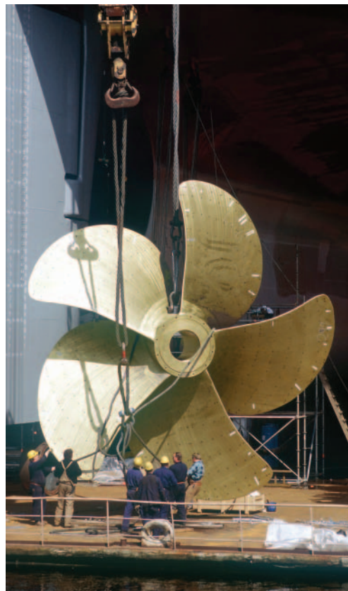
Operários a trabalhar (Cortesia de TKMS/HDW)
