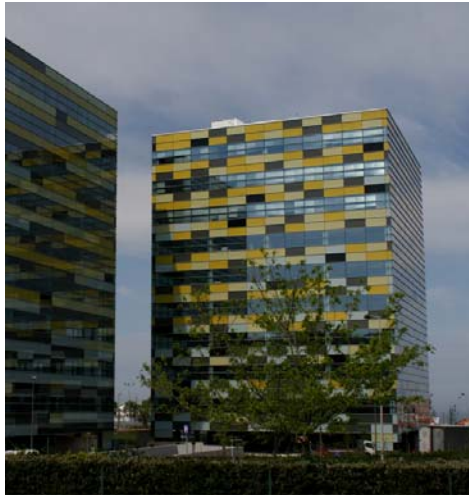
Figura 6: Novas instalações na Arrábida, em Vila Nova de Gaia: a torre da direita está inteiramente dedicada à ALERT.
